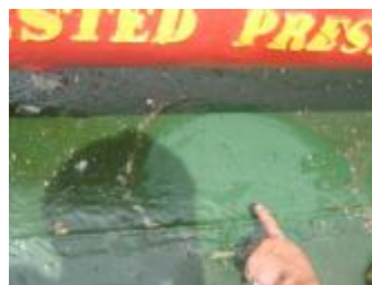
พื้นผิวจะแห้งและปราศจากไขมันโดยไม่มีกลิ่นและพื้นผิว
