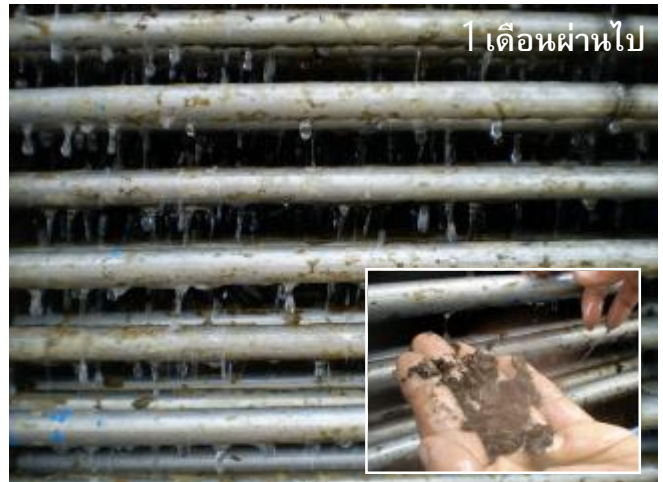
ท่อน้ำยาที่ตะกรันหลุดไปออกจากผิวท่อแล้ว
